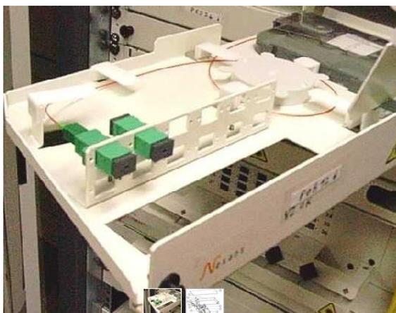
**Figure 9 : FTTE passif NRO - exemple de Bandeau Optique**
